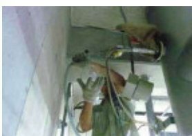
ボイラー排出ガス調査
