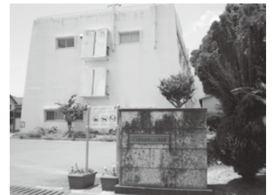
左の門柱には長崎県西彼保健所と印刷された白いプラスチック版が貼られています。
